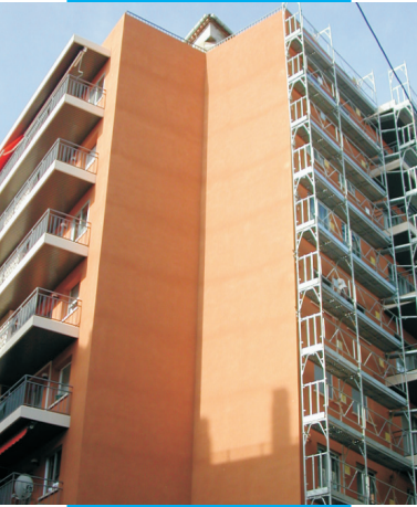
Παράδειγμα εφαρμογής Quarzolite Tonachino σε ιδιωτικό κτήριο στη Φιγέρες - Ισπανία
